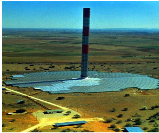
Fig. 5. Photo de la centrale à cheminée solaire de Manzanares.
